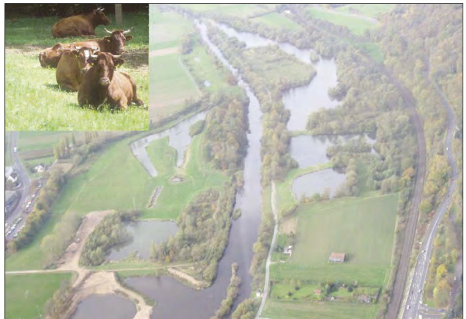
Blick auf die Renaturierungsmaßnahme unterhalb von Rotenburg
