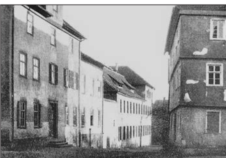
(1) Die alte Rosengasse; links das Waisenhaus, der Zwischenbau und der Westflügel des Gymnasiums.
