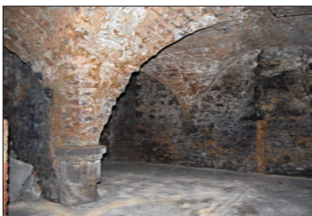
(1) Kellergewölbe aus der Franziskanerzeit (13. Jahrhundert).
