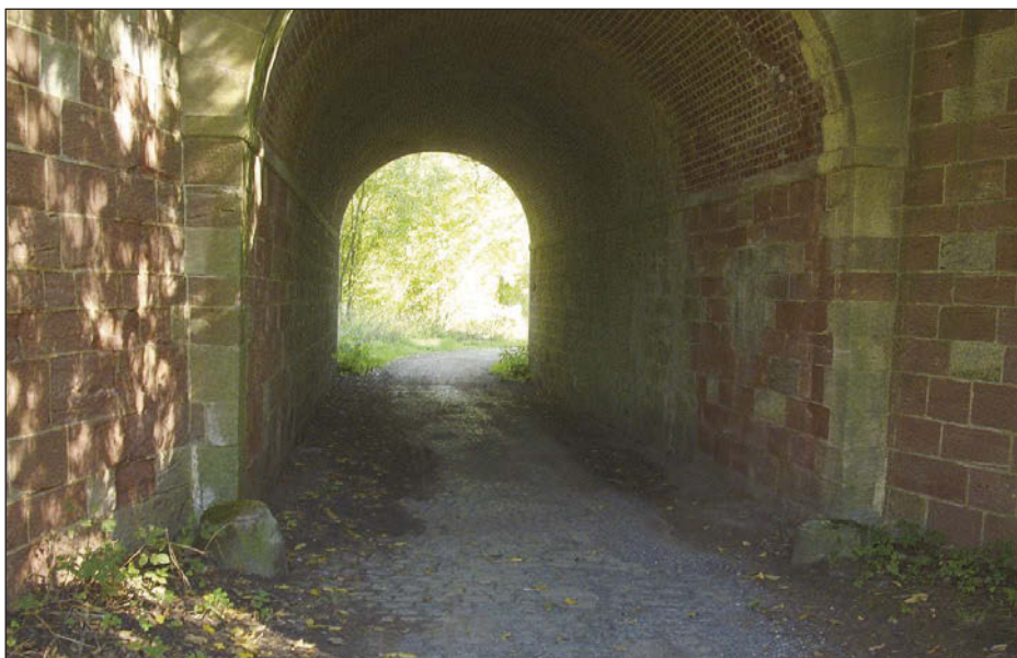
Rillensteine an einer Eisenbahnunterführung in Bebra-Weiterode.
