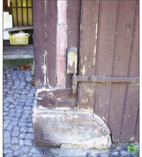
Radabweiser an einer Scheuneneinfahrt.
