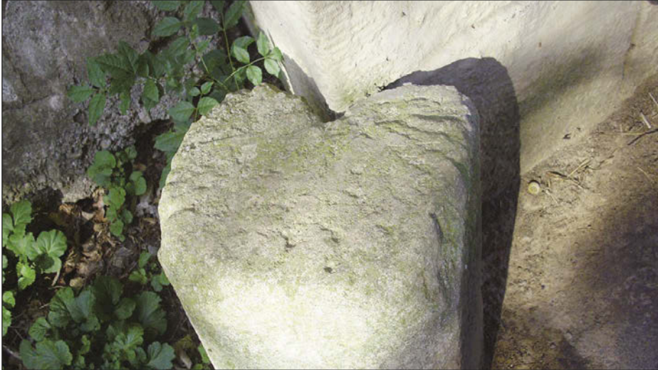
Dieser Rillenstein schützt eine gemauerte Kante vor Beschädigung durch Fahrzeuge.
