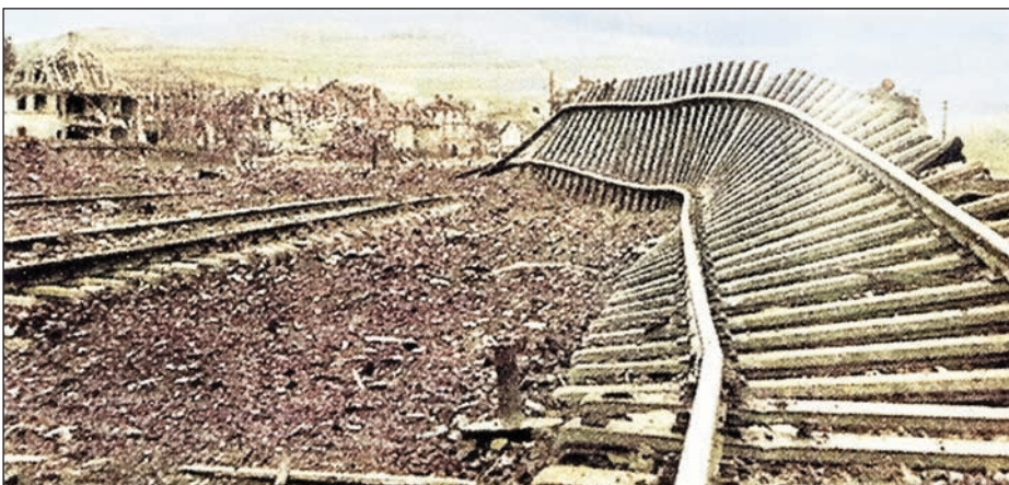
Zerstörte Gleisanlagen am Bahnhof Heimbaldshausen 1945.
