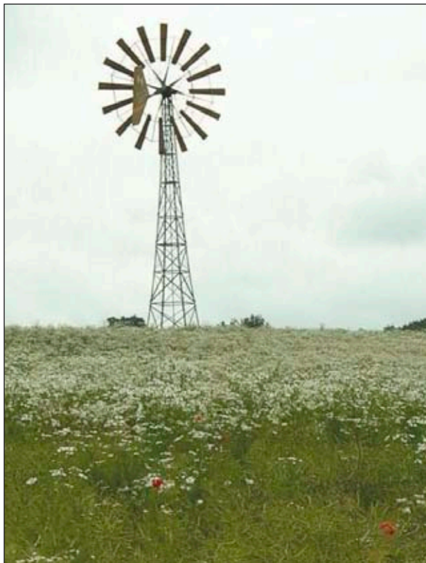
Das erste Windrad für Stromerzeugung im Kreis Hersfeld-Rotenburg. Die von den Schenkklengsfeldern als „Westernwindrad“ bezeichnete Anlage bestand aus einem 14 m hohen Gittermast und einem Windrad mit 16 Rotorblättern aus Polyurethan mit einem Durchmesser von 5,7 m und erbrachte eine Leistung von 10 Kilowatt.
