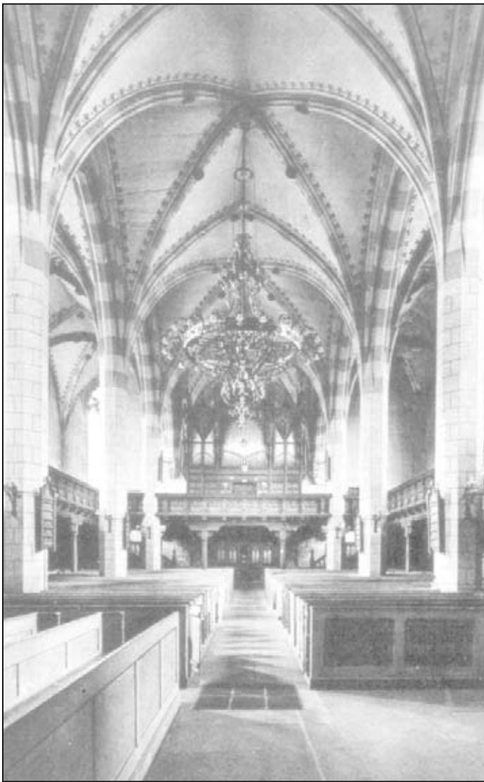
Blick vom Chor zur Orgel nach der Renovierung 1899.
