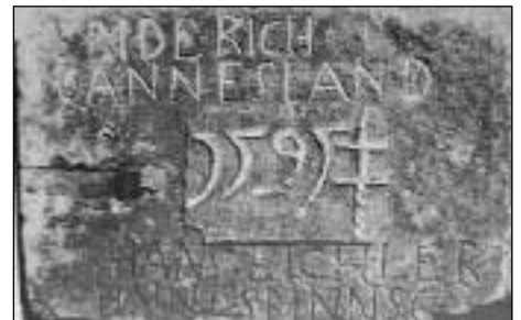
Älteste erhaltene Bauinschrift von der alten Fuldaer Brücke mit Lothringer Kreuz.
