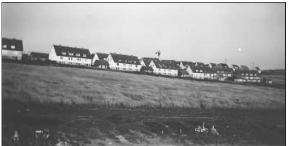
Die untere Reihe der Siedlungshäuser Königsbergerstraße kurz nach der Fertigstellung 1956/57. Blick von der gerade entstehenden Straße „Unter der Stiegel“ ostwärts in Richtung „Petersberg“. In der Bildmitte über die Häuser heraus ragend sieht man das Windrad des Brunnens Petersberg.
