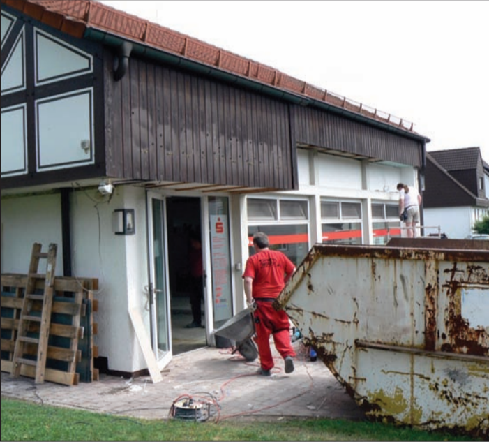
Aus Alt mach Neu: Bevor die Sparkassenfiliale umgebaut wurde, musste das Gebäude komplett entkernt werden.
