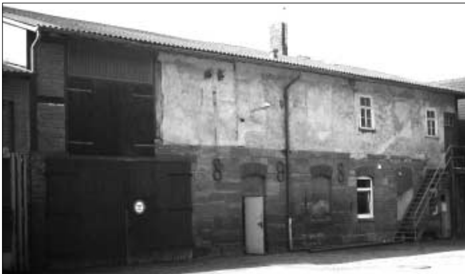
Foto 1: Südlicher Gebäudekomplex des Bauhofes der Gemeinde Philippsthal (ehemaliges Fabrikgebäude der Papier- und Pappenfabrik). Siehe Abb. 2 (Aufnahme E.-W. Schmidt, 2004)
