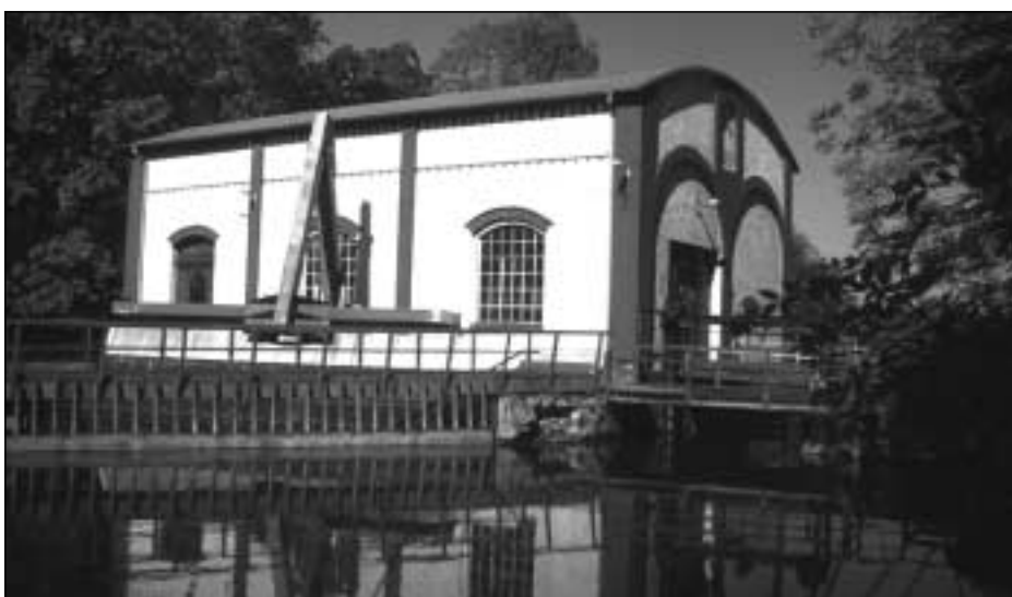
Foto 2: Wasserkraftwerk Philippsthal (Aufnahme E.-W. Schmidt 2003)
